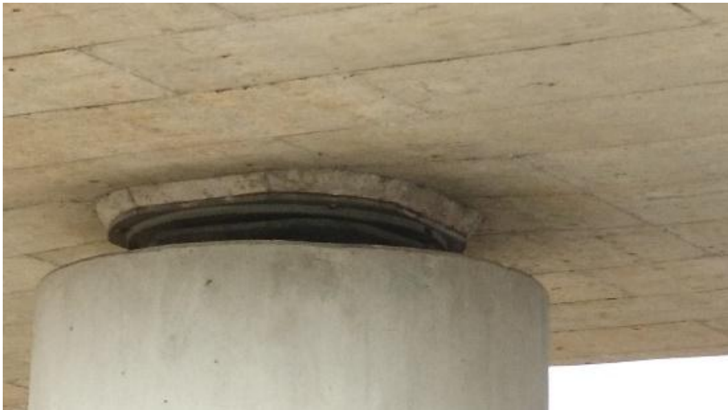
Bestandslager Pfeiler, Achse B und C: NGe/950 (BC)
